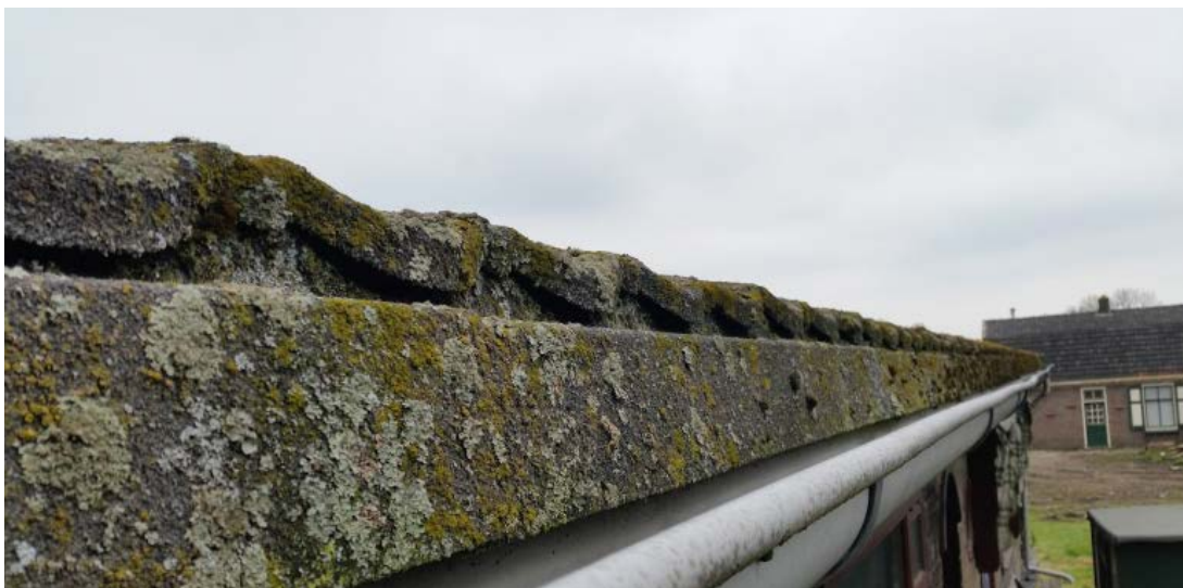
Het dak van de woonboot, voorzien van bitumendakplaten met dakpanprofiel.
