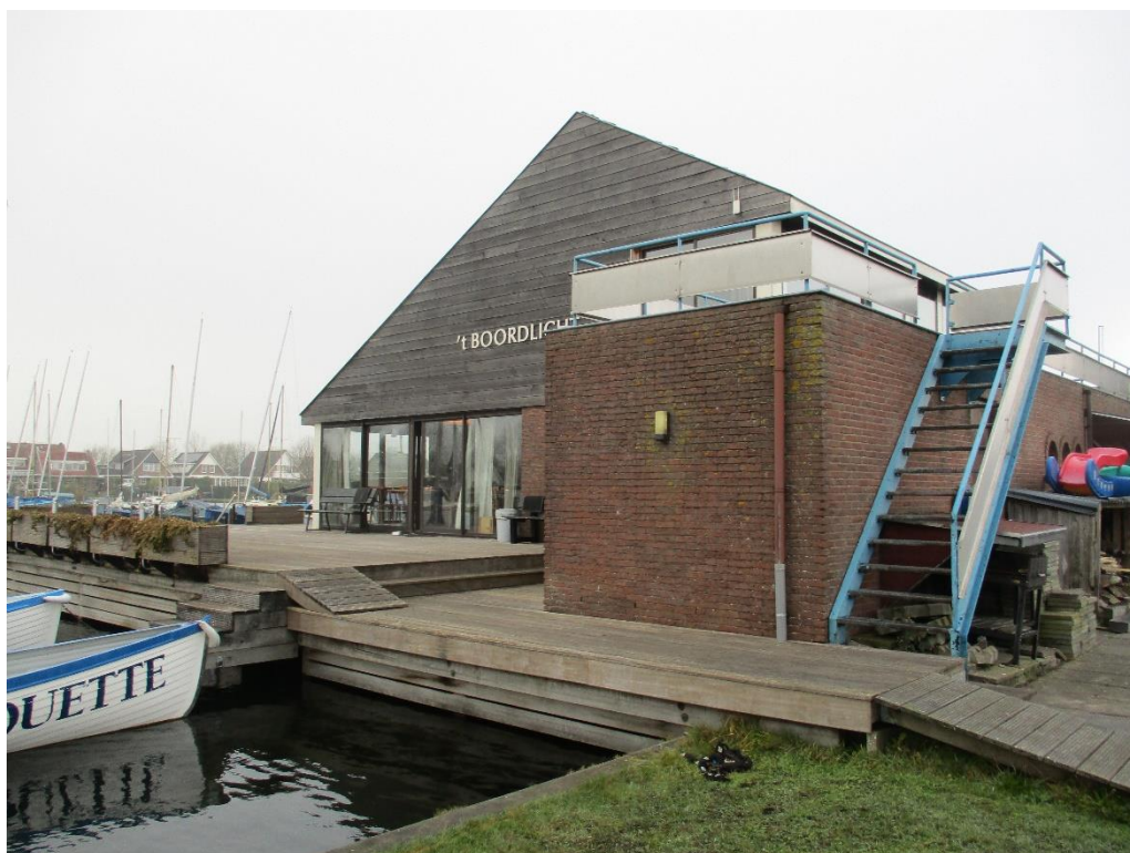
Figuur 1 De planlocatie is gelegen aan de Dammerweg 62 te Nederhorst den Berg en bestaat uit een gemetselde spouwmuur met een zadeldak met dakpannen en een aanbouw.
