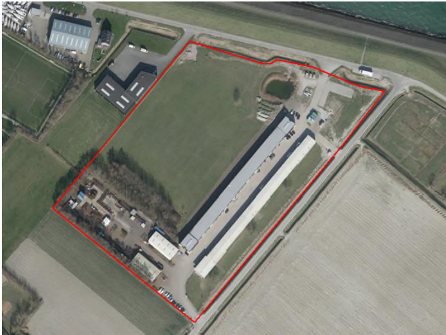
Figuur 4 - locatie - betonwapening producent
