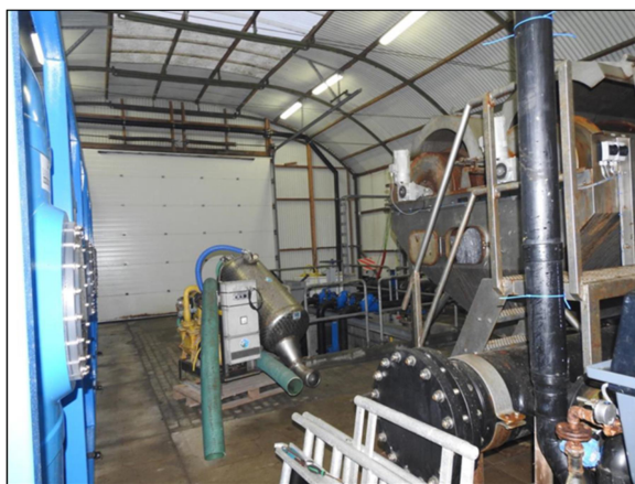
Figuur 3. Binnenzijde bestaande nissenhut
