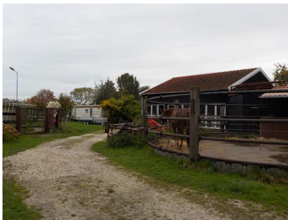
Foto 4. Fundatie van afgebrande schuur/stallen
