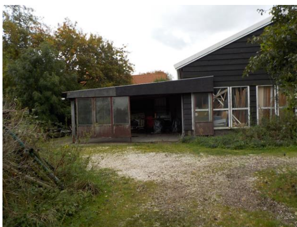
Foto 15. Achterzijde schuur (erf)
