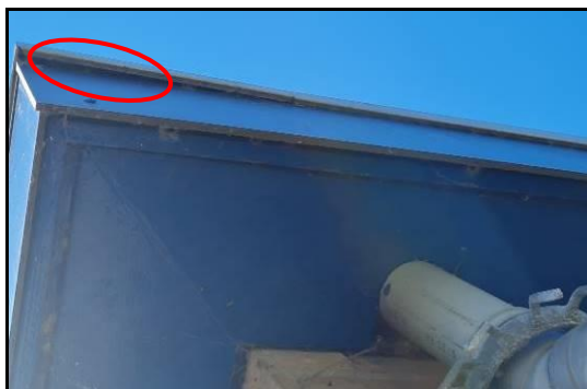
Afbeelding 7: Mogelijke toegang voor verblijfplaats vleermuizen in deelgebied D
