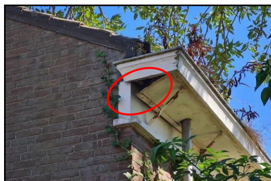
Afbeelding 8: Mogelijke toegang voor verblijfplaats vleermuizen in deelgebied D
