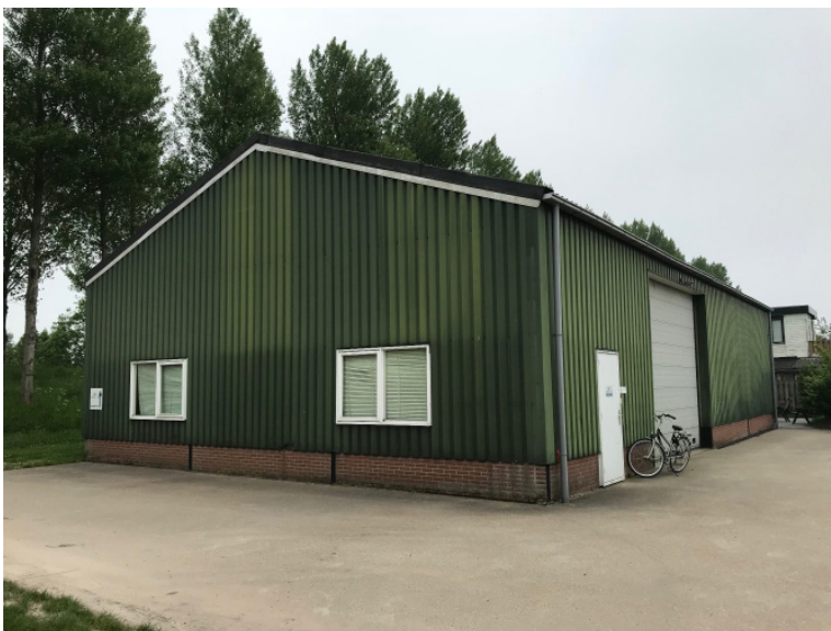
Figuur 15: Terreinverharding t.p.v. bouwlocatie
