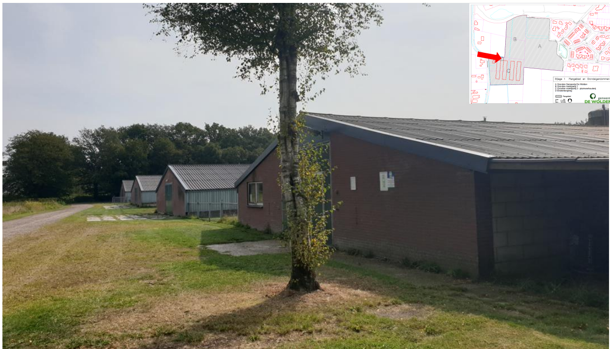
Figuur 2.5 Aanwezige kippenchuren. In de inzet is de locatie van de foto opgenomen.
