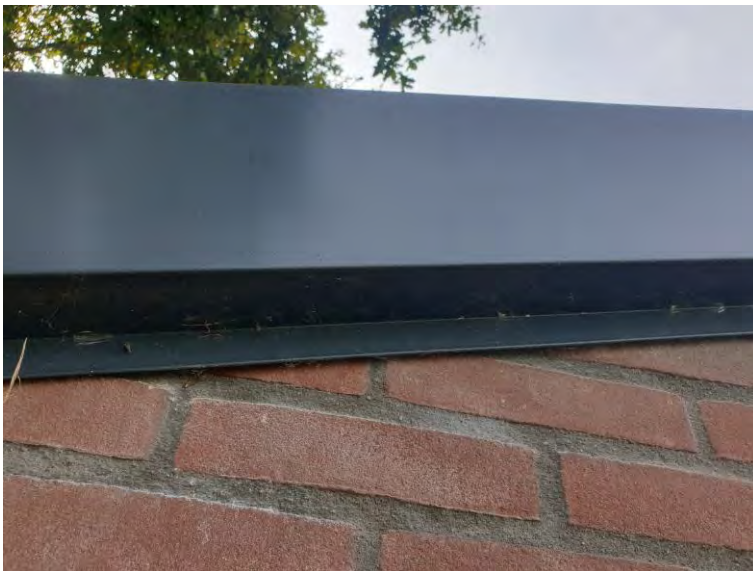
Figuur 4.3 Impressie dakrand kippenschuren, hierin zijn geen openingen aanwezig en is sprake van een strakke afwerking.
