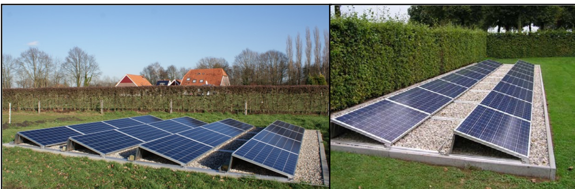
Afb. 9 & 10: Zonnepanelen in de tuin, binnen het bouwblok
