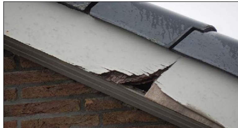
Figuur: opening in de daklijst in de zuidwestelijke gevel van de woning welke verblijven kan bieden aan vleermuizen.
