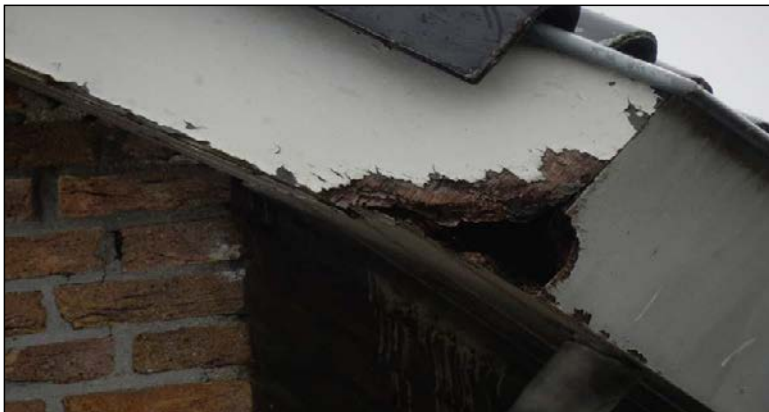
Figuur: opening in de daklijst in de zuidwestelijke gevel van de woning welke verblijven kan bieden aan vleermuizen en waar een huismus in zou kunnen broeden.
