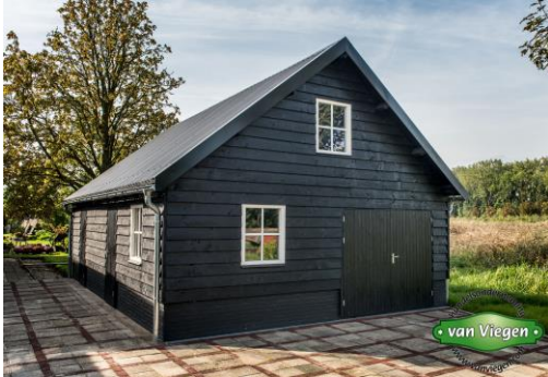
Figuur 9 Referenties landelijk bouwen, dorps en kleinschalig met natuurlijke kleuren en materialen: nieuwbouwboederij in baksteen met wolfseind door Architectenbureau Drijvers Oisterwijk, schuurwoning met rietenkap door 01 Architecten en voorbeeld van een schuur met kap in dondere kleuren en natuurlijke materialen door van Vliegen Handelsonderneming
