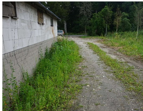
Pad met puinverharding
