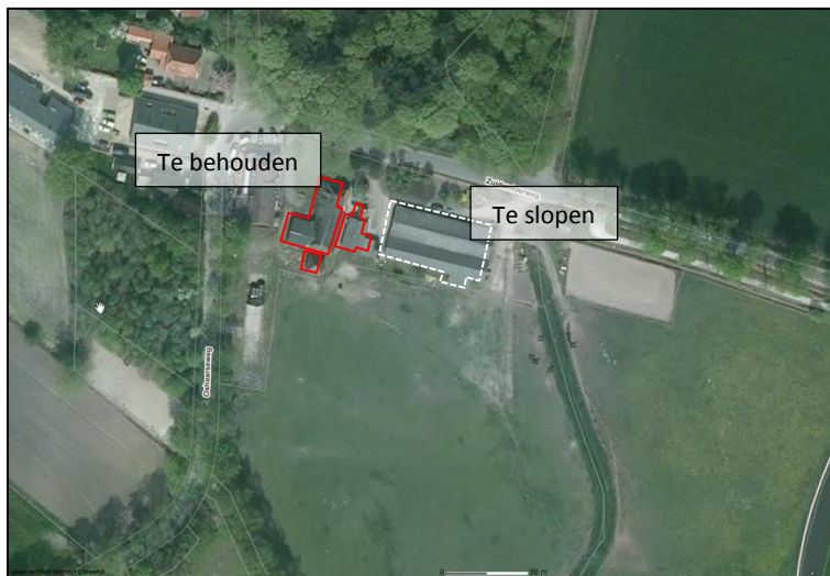
Figuur 9 Overzicht te slopen stallen 785 m2 en te behouden bebouwing
