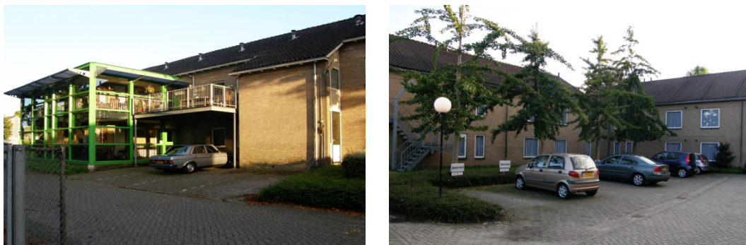
Figuur 3 De meest noordelijke bebouwing van “De Priensenije” (links) en de parkeerplaats tussen de woningen in het zuiden van het plangebied.
