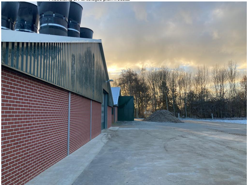
• Afbeelding 6: Achterzijde pluimveestal
