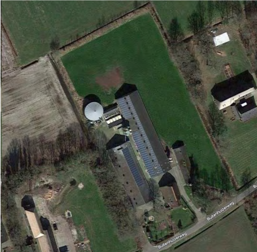
Figuur 2.2 Luchtfoto Buitenhuizerweg 4
