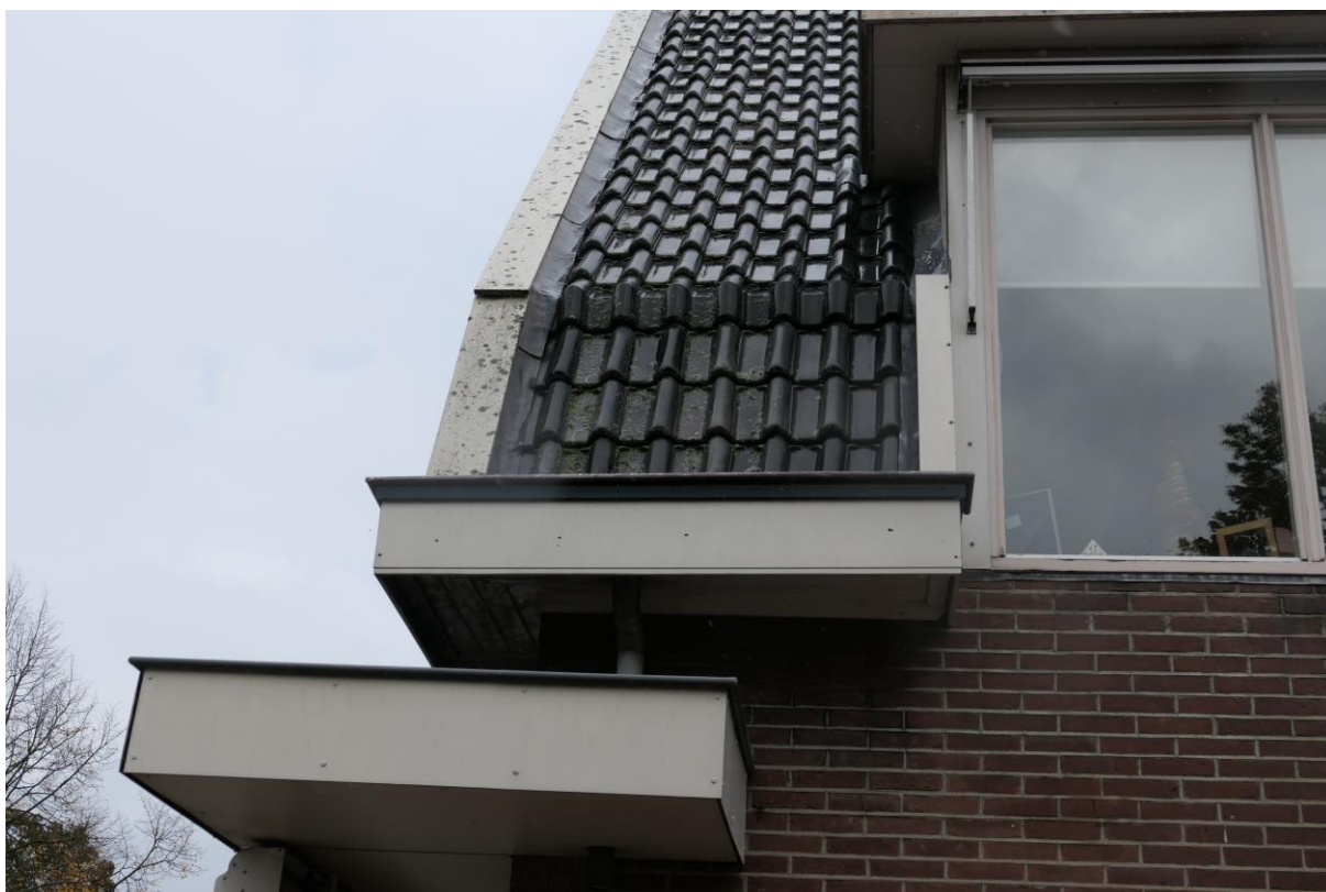
Afbeelding 4.3.2 Dakgoten strak afgewerkt.
