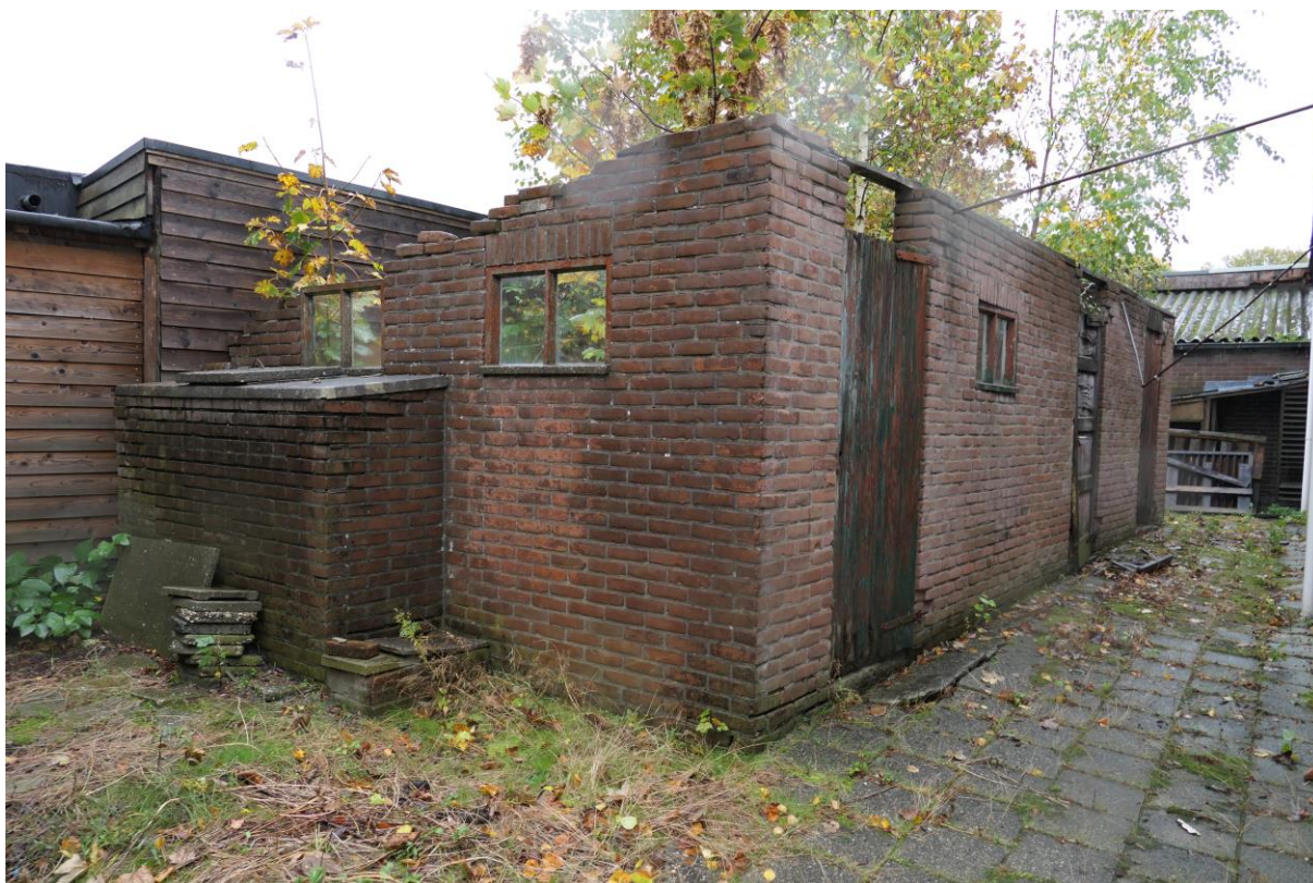
Afbeelding 1.7 Opslagschuur noordzijde projectgebied.
