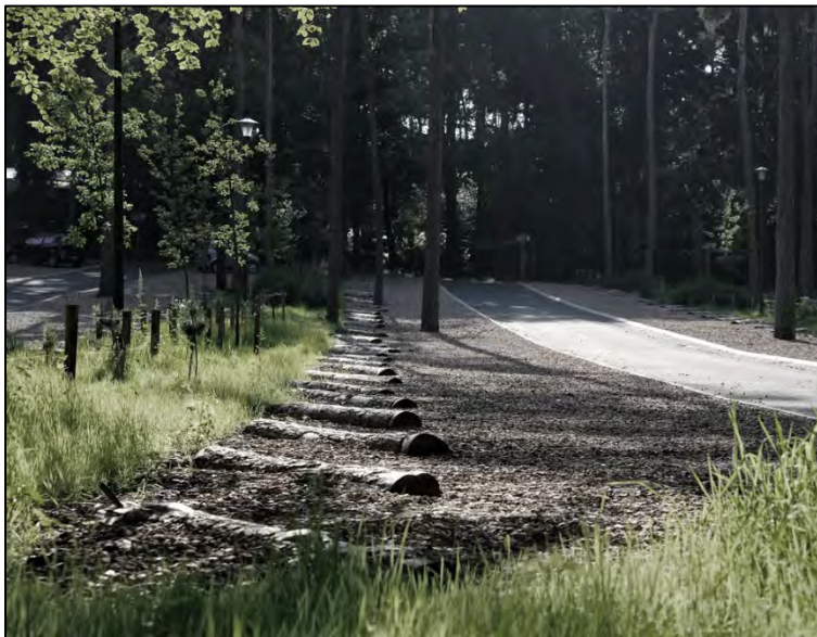
Figuur 37 Halfverharde parkeerplaats met boomstammen als stootblokken, langs de weg (visserslodges)
