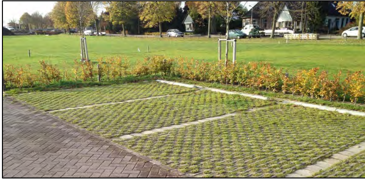
Figuur 36 Parkeren grasbeton
