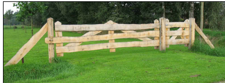
Figuur 22 Kastanjehouten landhek
