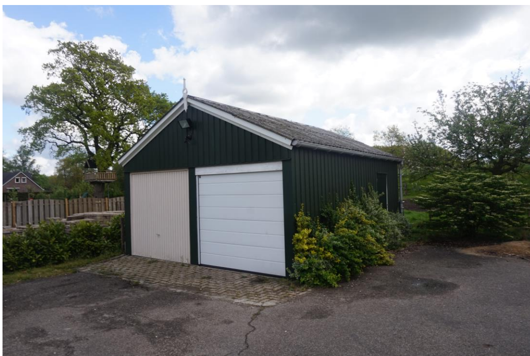
Figuur 1.5 Te slopen garage A.
