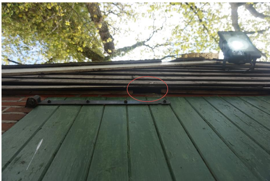
Figuur 3.2. Ruimte tussen houtbetimmering bij gebouw D.
