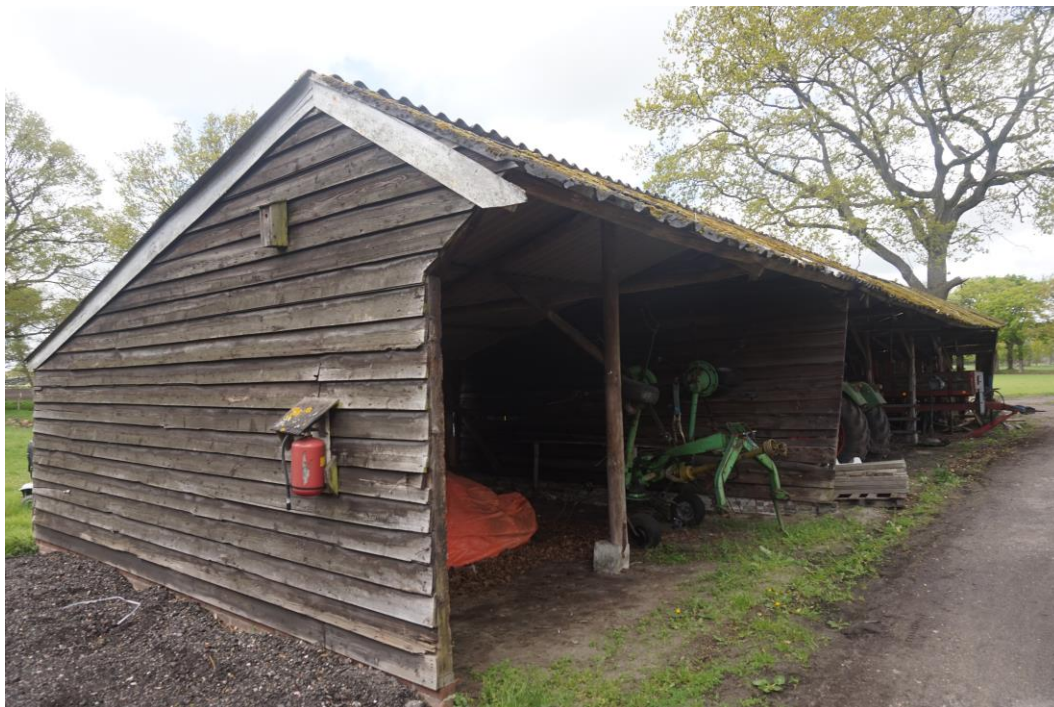
Figuur 1.4 Te slopen kapschuur E.
