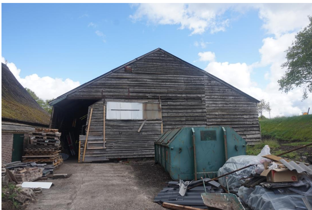
Figuur 1.3 Te slopen schuur B.
