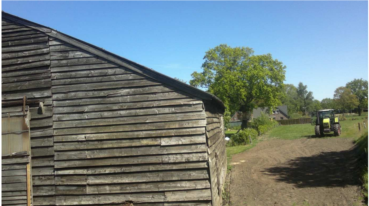
Foto 6. Dak schuur oostzijde
