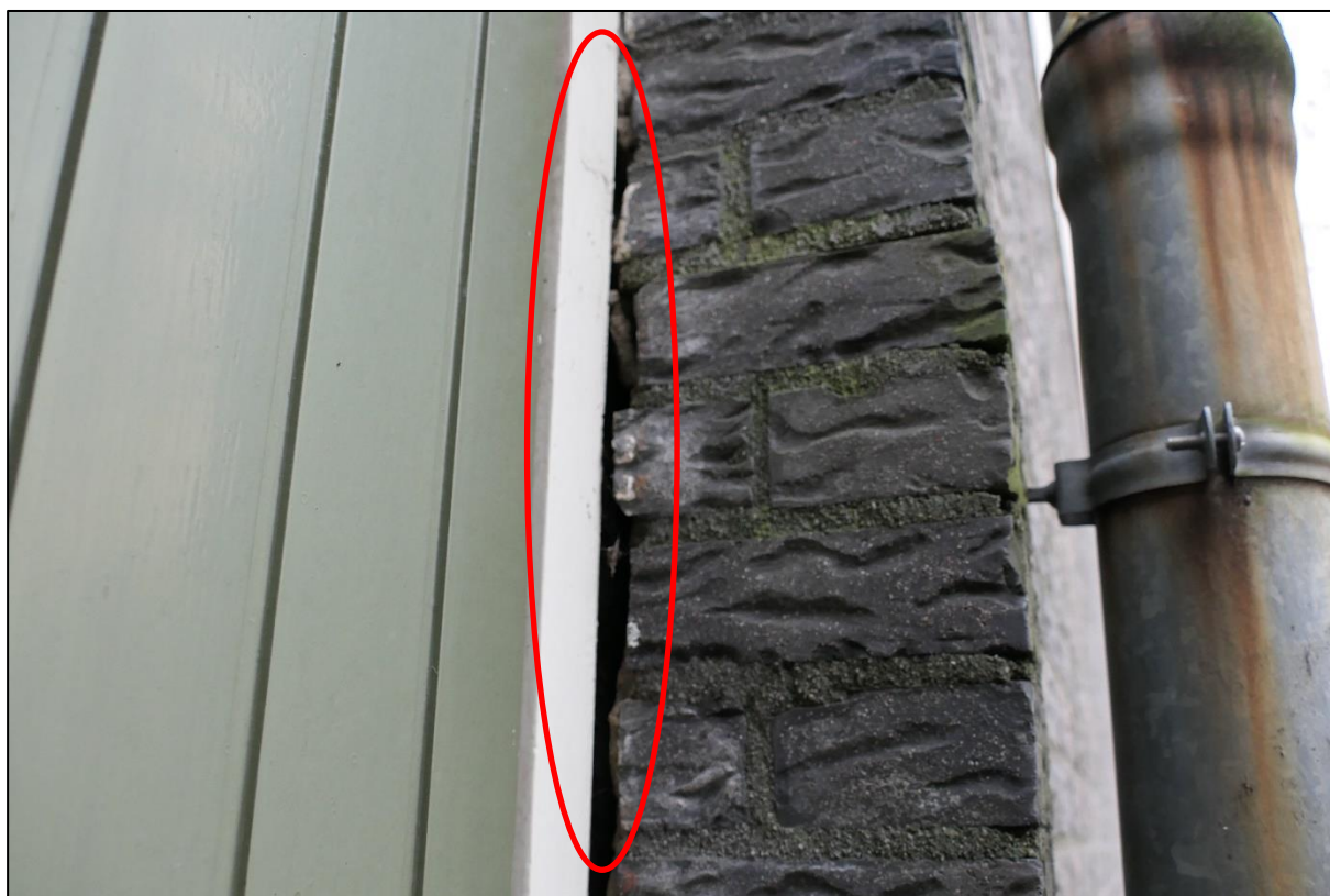
Figuur 4.12 De buitengevel van de sporthal biedt op meerdere plekken mogelijk toegang tot de spouw.
