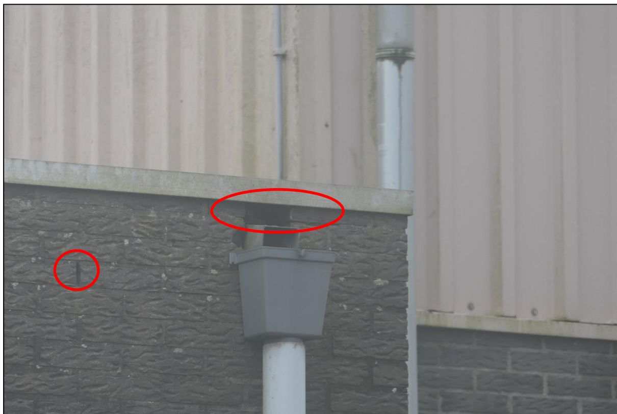
Figuur 4.11 De sporthal biedt op meerdere plekken geschikte toegang tot de spouw.
