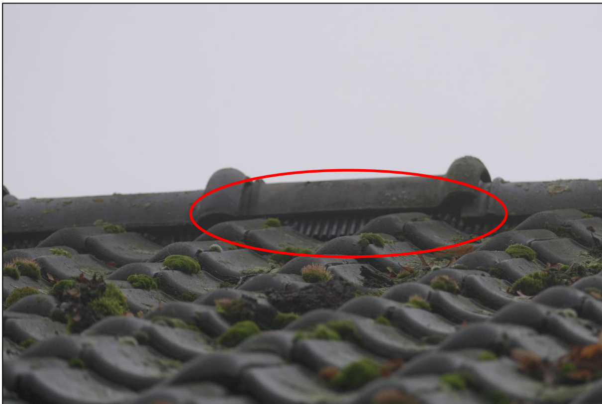
Figuur 4.4 Bij lagere gebouw van de gymzaal (noordzijde) is vogelwering aanwezig waardoor huismus hier niet tot broeden zal komen.
