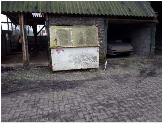
Bovengrondse dieseltank bij noordelijke loods
