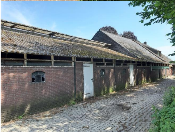
Figuur 5. Foto's plangebied (resp. gebouw 1 t/m 7 van figuur 4).
