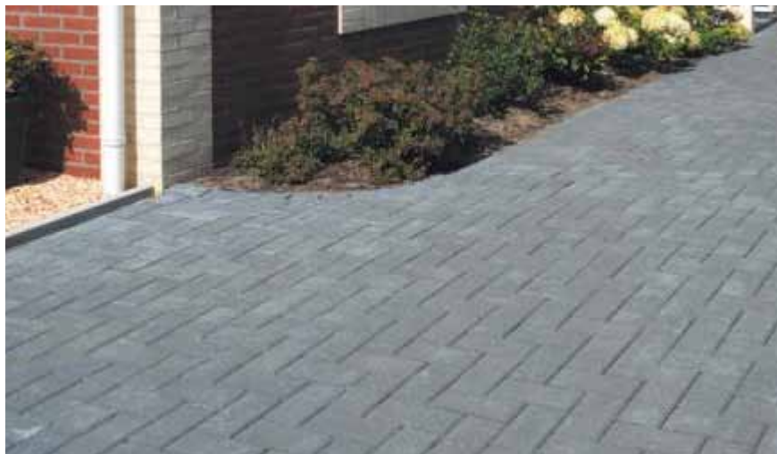
Fig. 17 Referentie betonklinkerverharding
