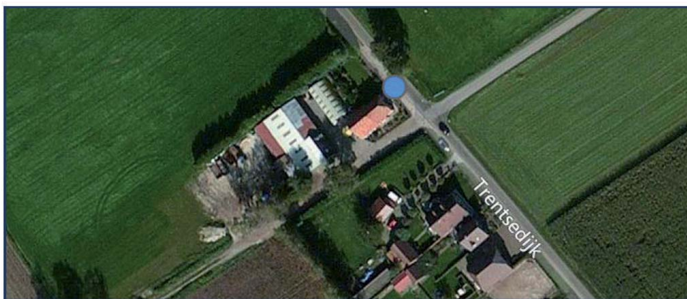
Fig. 2: luchtfoto bovenaanzicht bedrijf (bron: Bing maps)
