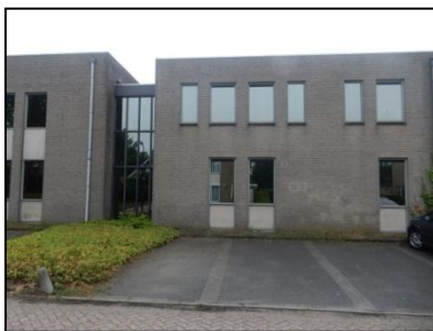
Figuur 3. Noordzijde kantoorpand.
