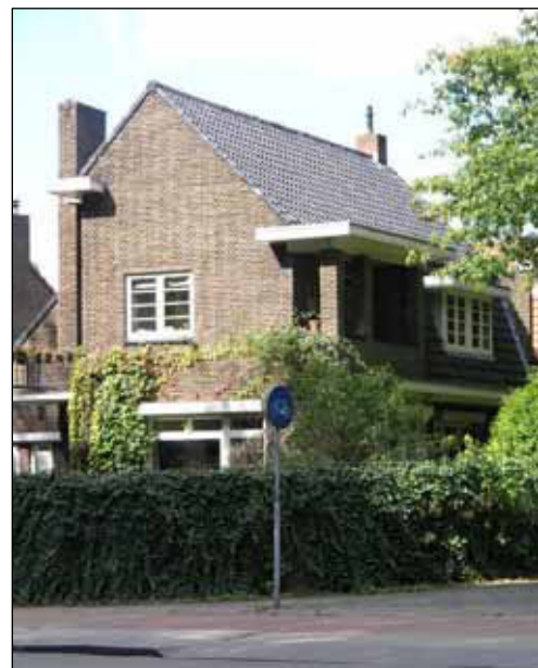
Afb. 14 overstekende gootpartijen en luifels
