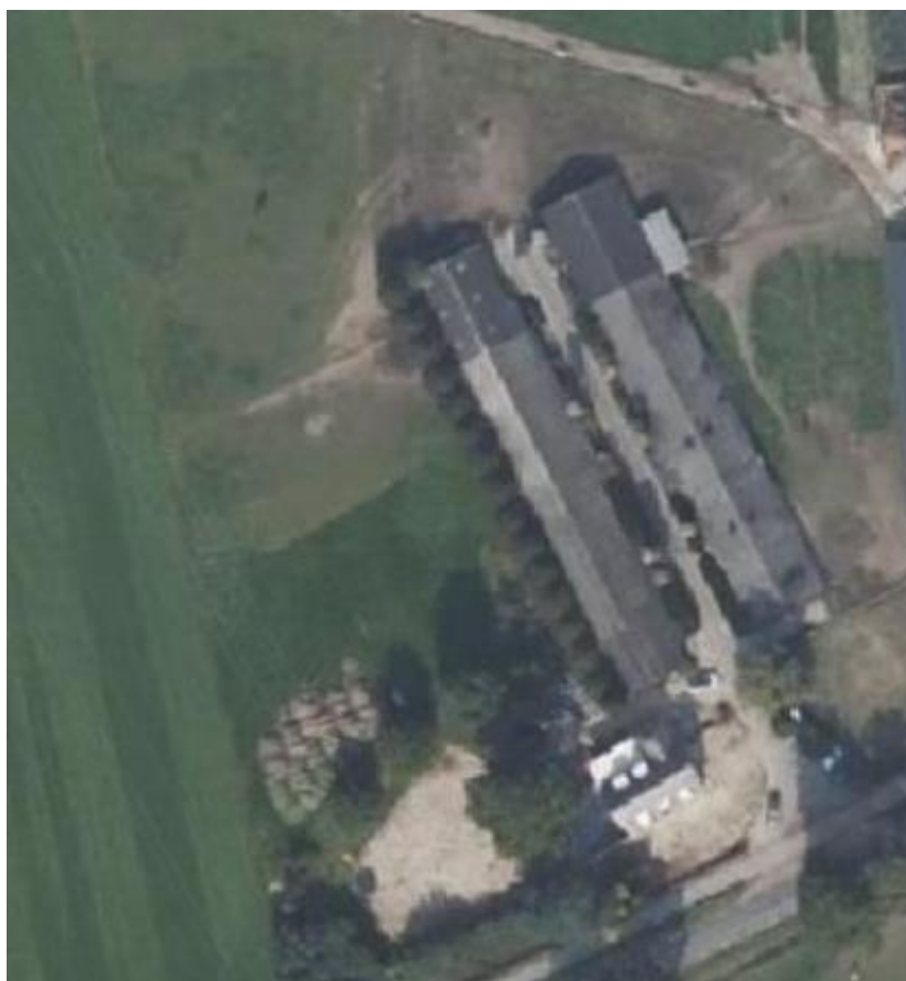
Figuur 2.4: Luchtfoto Millseweg 18 (Bron: PDOK viewer)
