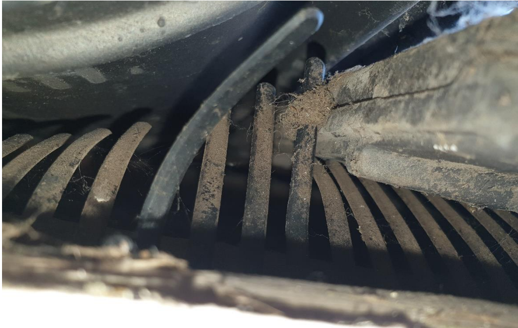
Figuur 4 Onder het dak van de woning is vogelschroot aangebracht.
