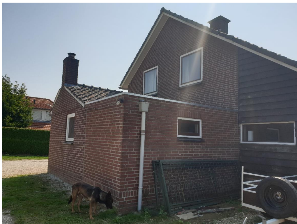
Figuur 1 De woning (W) is opgetrokken uit een gemetselde muur met spouw en zadeldak met dakpannen.
