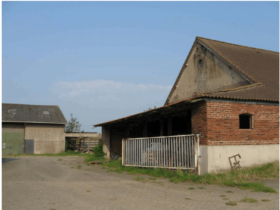
Afbeelding 2: De bestaande bebouwing binnen het plangebied voor de nieuwe varkenshouderij.
