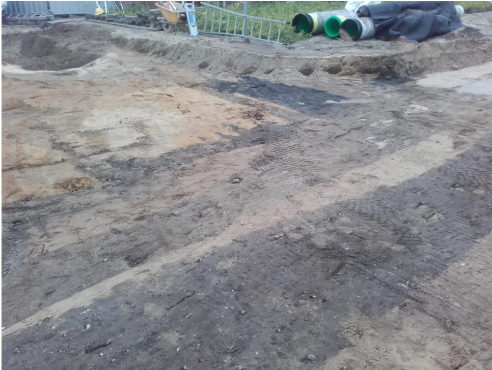
Afbeelding 3: De "grijze banen" van eerdere graafwerkzaamheden direct langs de gesloopte delen
