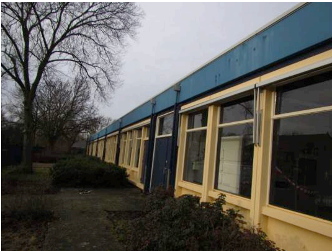
Figuur 2 Gevel langs de Toermalijnlaan.
