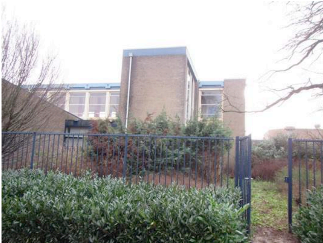
Figuur 4 Trappenhuis aan de zijde van de Wolweversgaarde.
