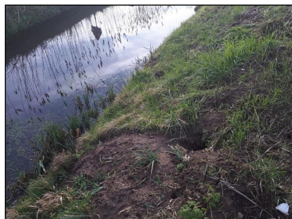
Figuur 10. Hol nabij de sloot ten zuiden van de onderzoekslocatie.
