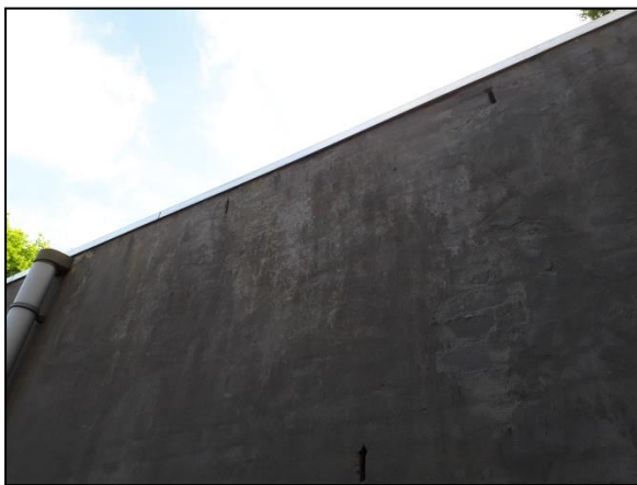
Figuur 9. Open stootvoegen.
