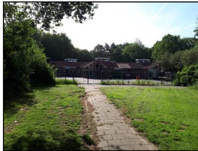
Figuur 4. Vooraanzicht van het schoolgebouw.
