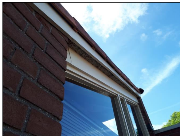
Figuur 10. Ruimte achter dakrand en betimmering.
