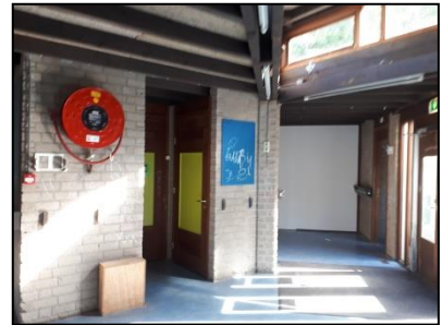
Figuur 5. Binnenzijde schoolgebouw.
