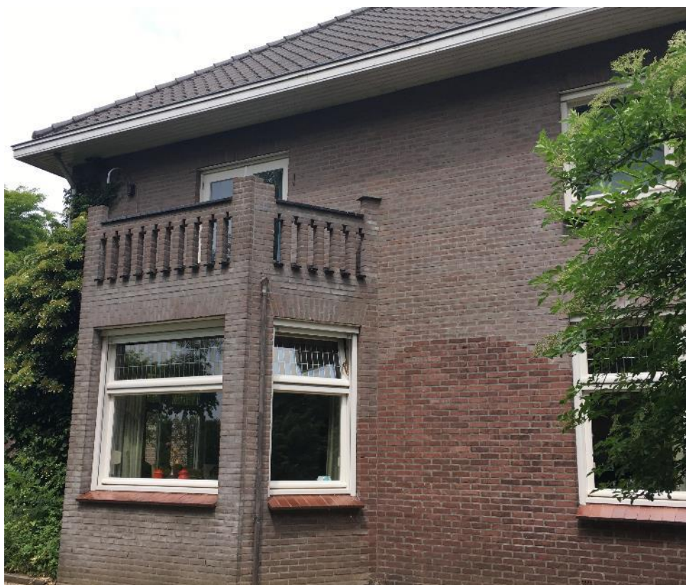
Figuur 2 De woning op het perceel zal tevens worden gerenoveerd. De woning bevat meerdere openingen en kieren die geschikt zijn voor huismus en vleermuizen.
