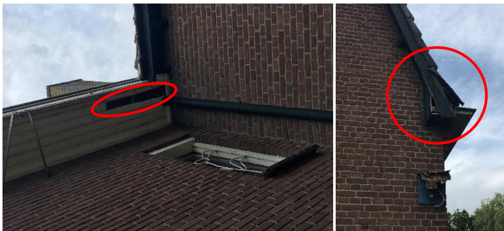
Figuur 3 De woning bevat verschillende kieren en openingen die geschikt zouden kunnen zijn voor vleermuizen.
