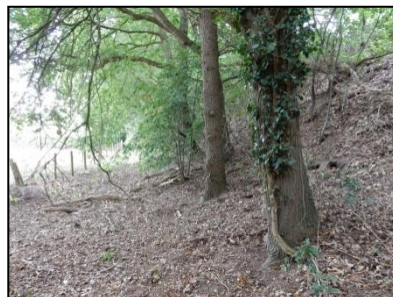
Figuur 10. Spoortalud t.h.v. Molenhoek
