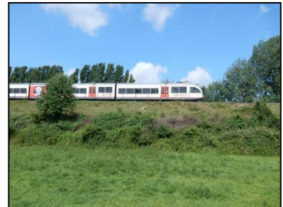
Figuur 7. Talud en hagen.
