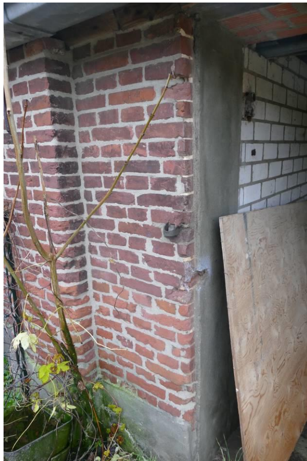
Figuur 28 – Een gepend kozijn met sporen van hergebruik.
