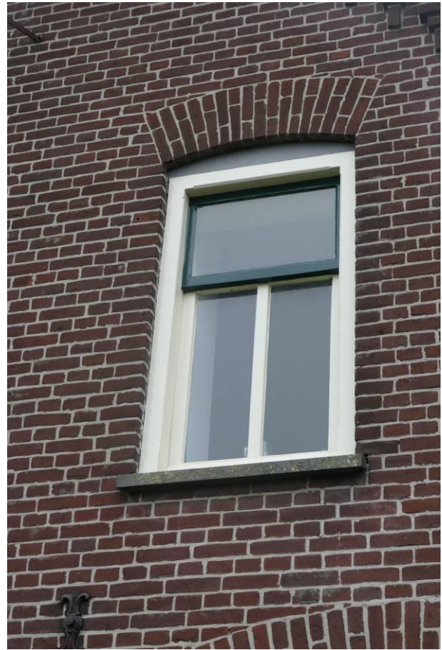
Figuur 11 – Een zolderraam.
