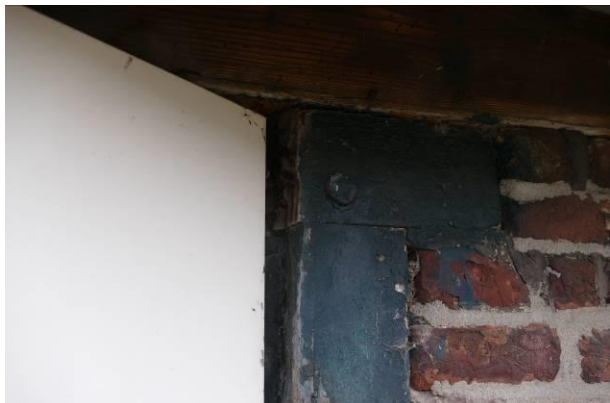
Figuur 28 – Een gepend kozijn met sporen van hergebruik.
