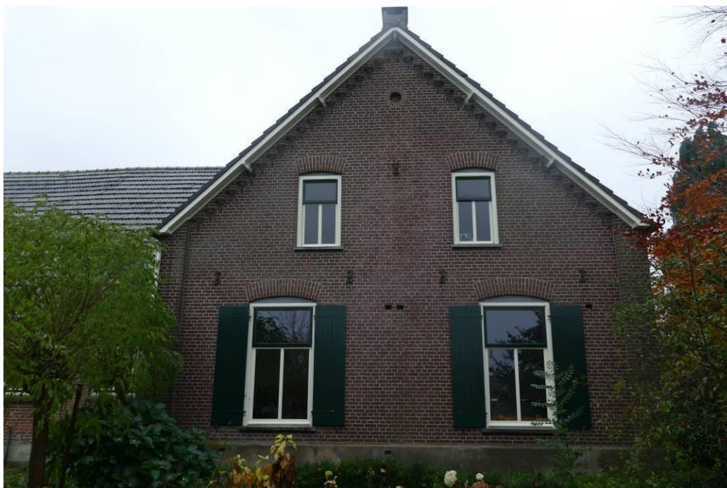
Figuur 16 – De noordgevel van het woonhuis.
