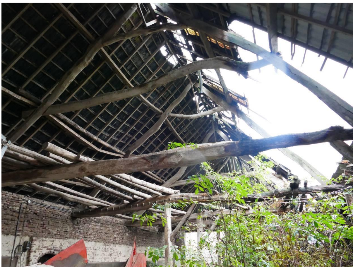
Figuur 38 – De gebintconstructie van de schuur met zowel links als rechts een kopbalkconstructie. De is goed te zien op het tweede gebint in deze foto.
