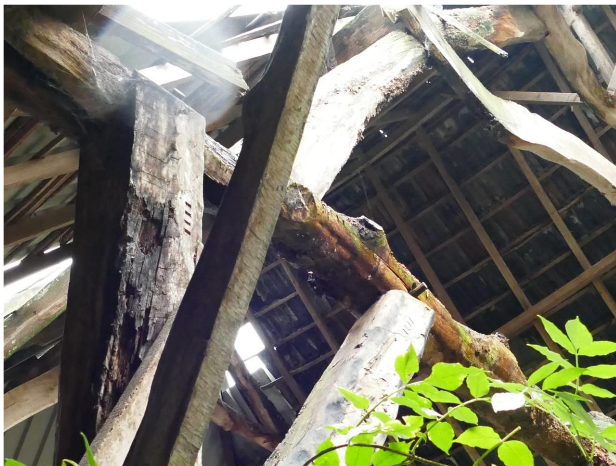
Figuur 45 – Het vierde gebint. De telmerken zijn op deze foto op zowel de stijl als de dekbalk en de schoor te zien.
