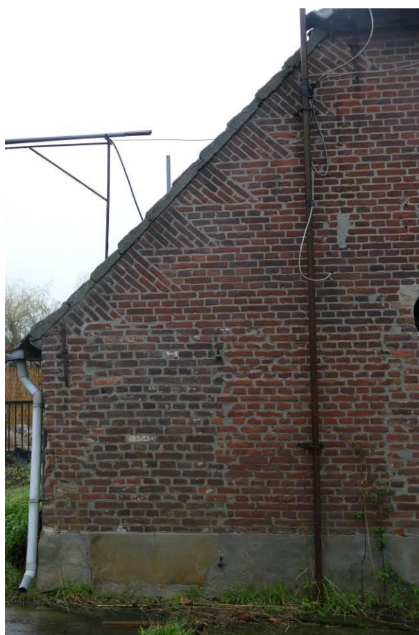
Figuur 25 – Een dichtgezette loopdeur in de oostgevel.
