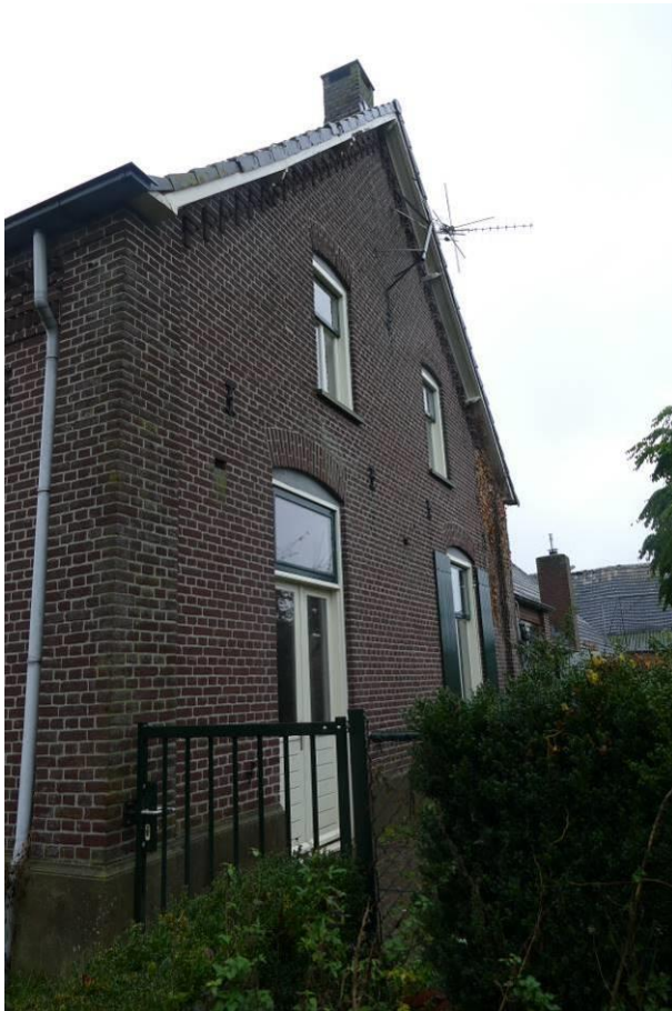
Figuur 10 – De zuidgevel van het woongedeelte.
