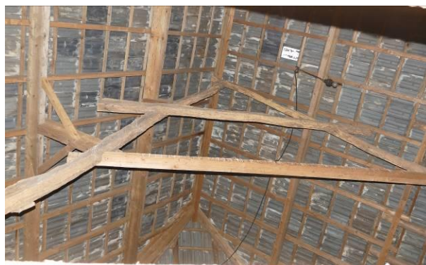
Figuur 35 – Een A-spant.
