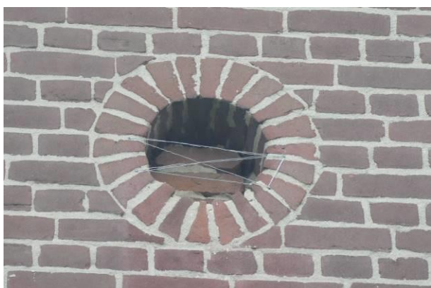
Figuur 18 – Het oeil-de-boeuf in de noordgevel.
