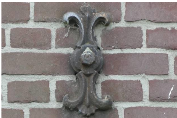
Figuur 6 – Een sierlijk uitgevoerd anker.
