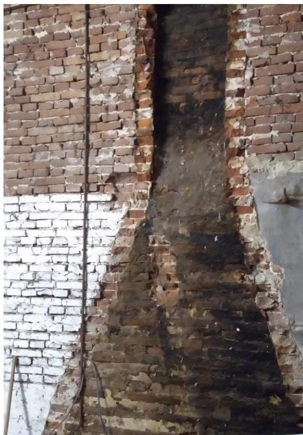
Figuur 31 – De afdruk van de rookafvoer in de brandgevel.
