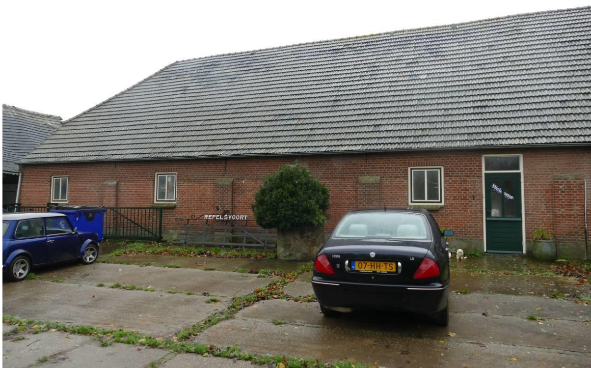
Figuur 20 – De noordgevel van het bedrijfsgedeelte.
