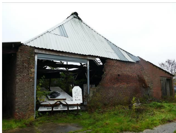
Figuur 37 – Zuidgevel van de schuur met links de andere opening naar de deel.
