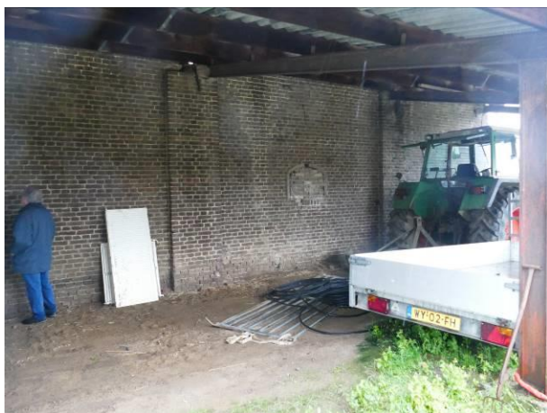
Figuur 39 – De blinde westgevel van de schuur.
