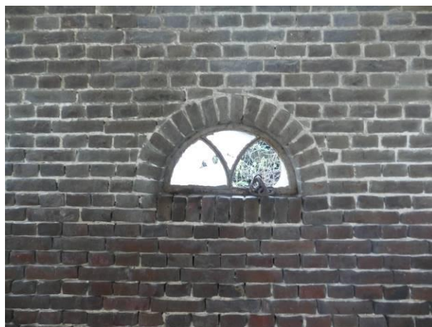
Figuur 40 – Het halve maantje in de westgevel.
