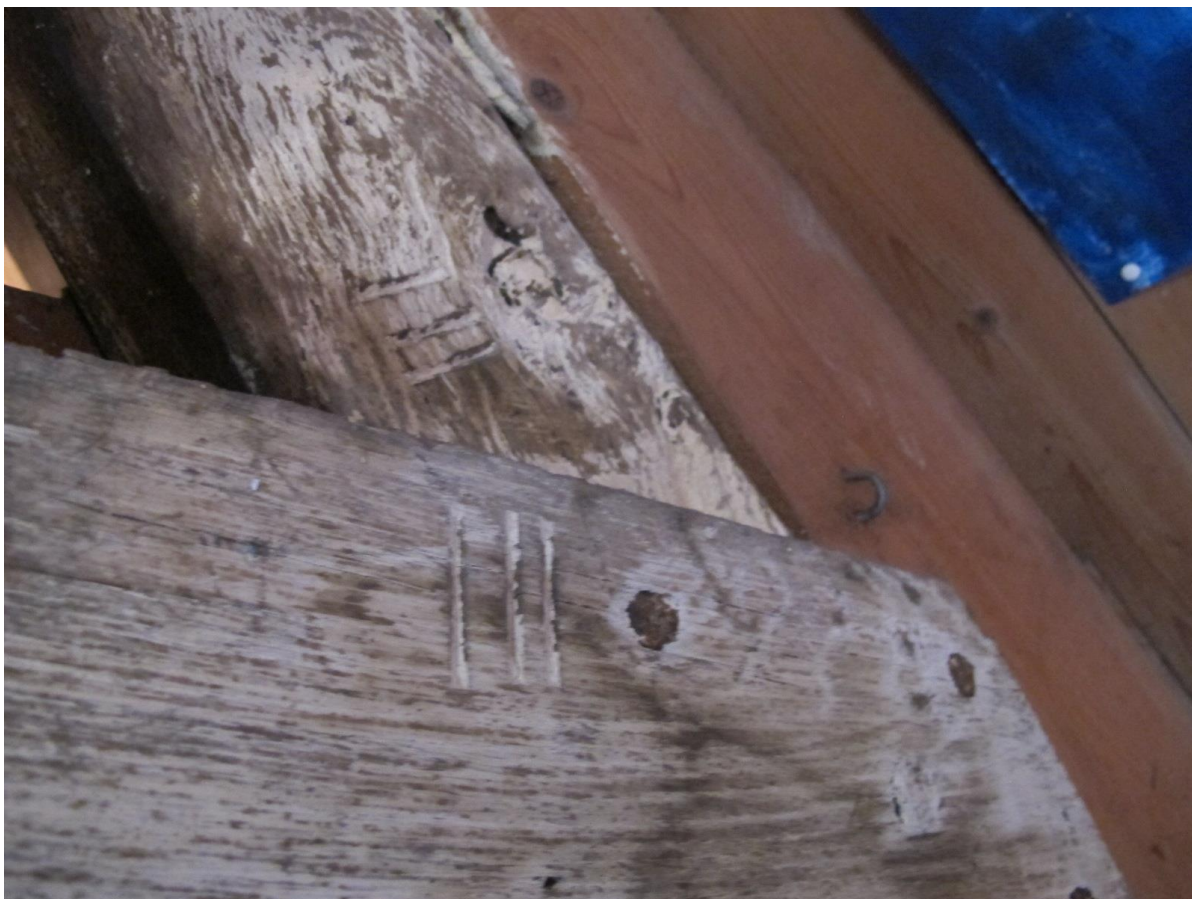
Overhage 16-18; Gehakte telmerken III op kapjuk woongedeelte.
