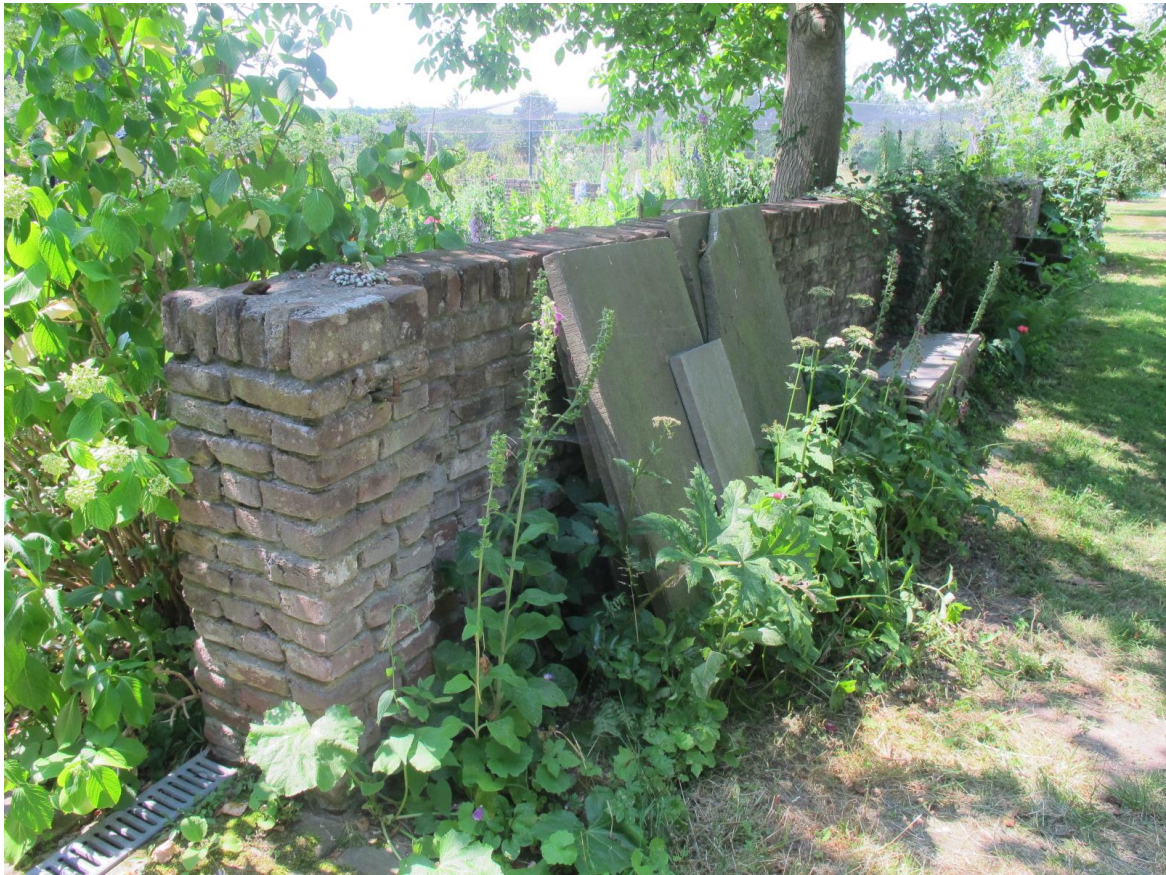
Het in het recente verleden opnieuw opgemetselde zuidelijke deel van de tuinmuur.
