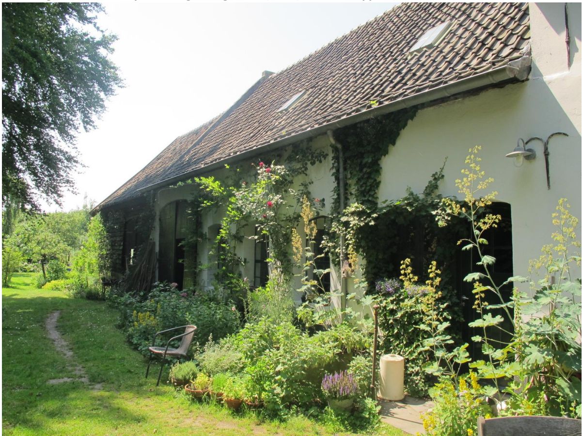
Overhage 16-18; Zuidgevel bedrijfsgedeelte.
