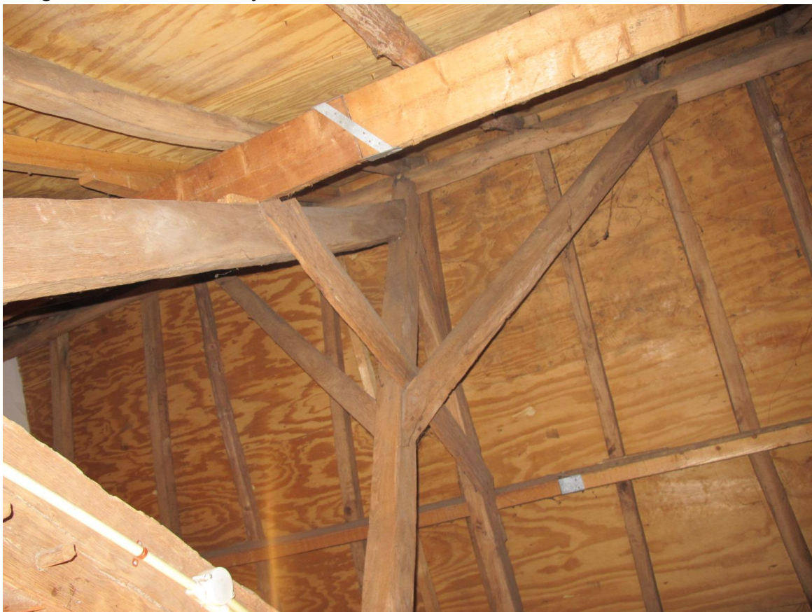
Overhage 16-18; Nokconstructie kap bedrijfsgedeelte.
