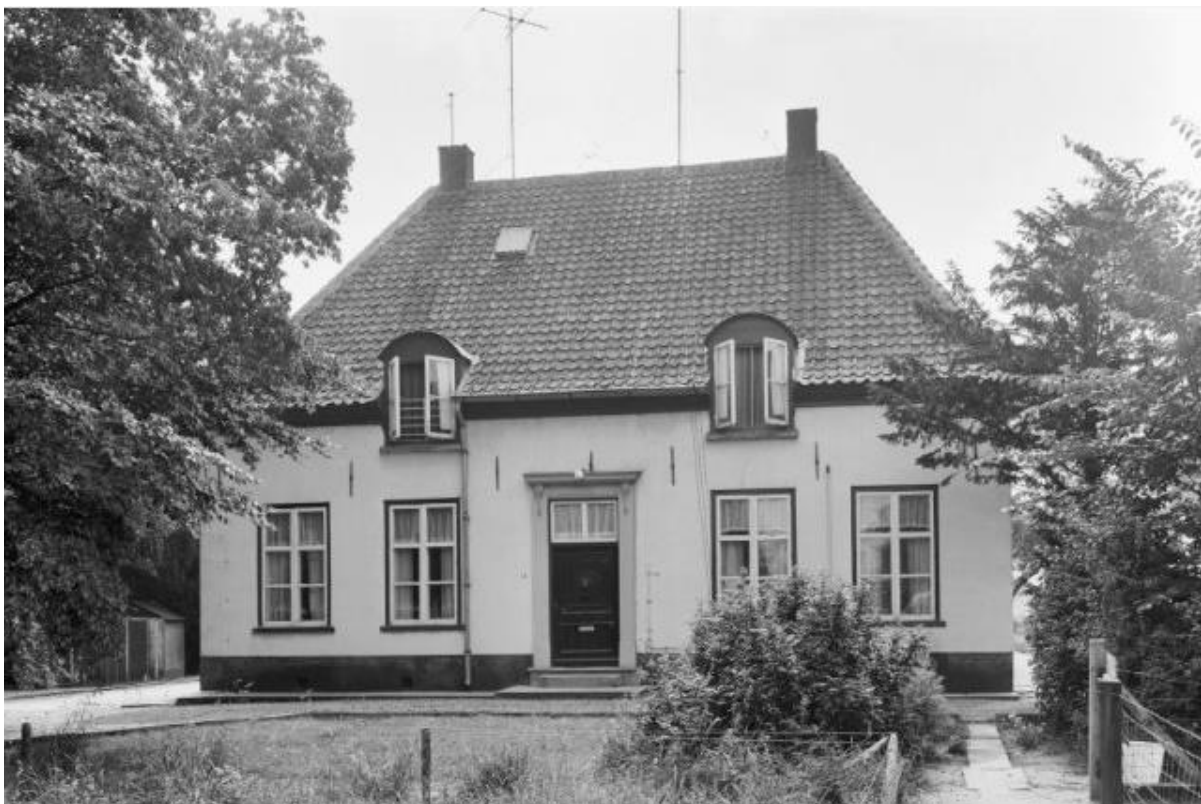
Overhage 16-18, voorgevel. Foto G. Dukker 1968 Beeldbank RCE
