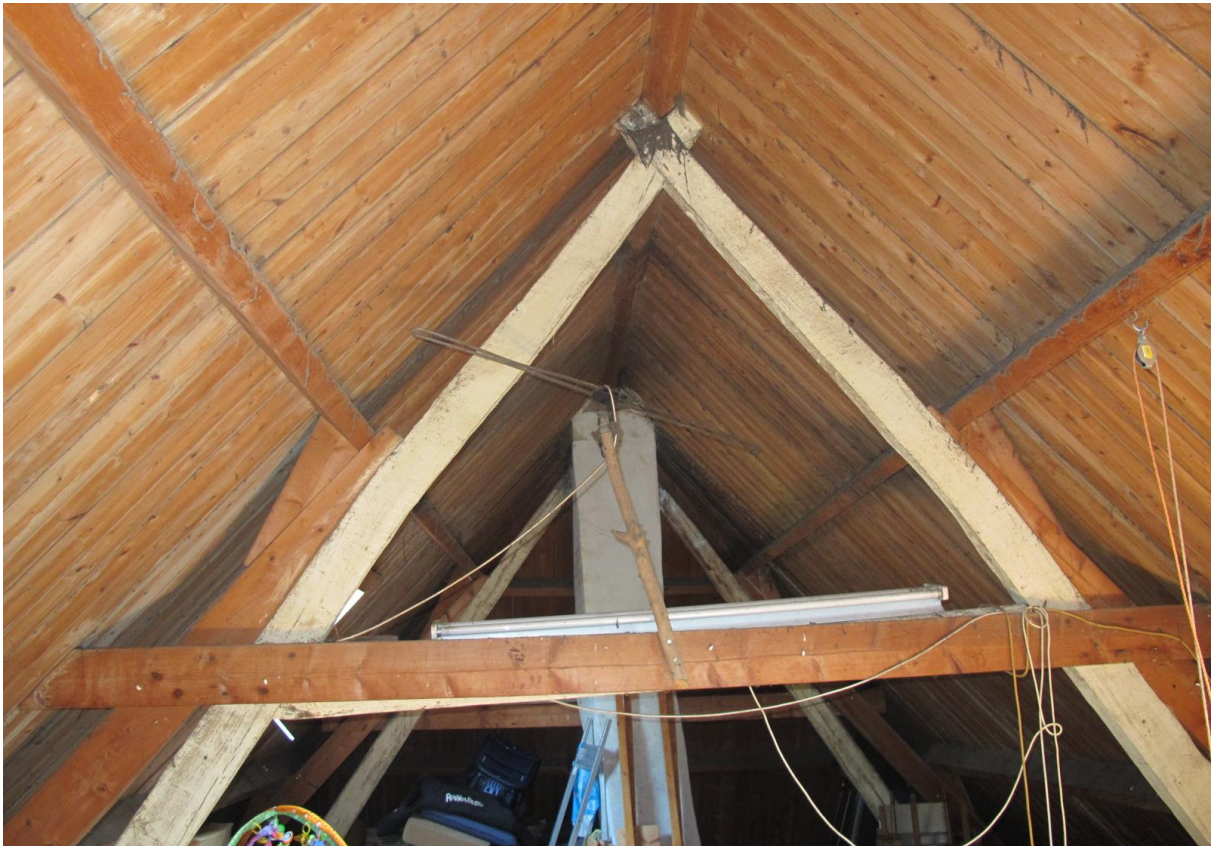
Overhage 16-18; A-spanten zolder/vliering voorhuis. Let op jongere kap die daar overheen is gebouwd.
