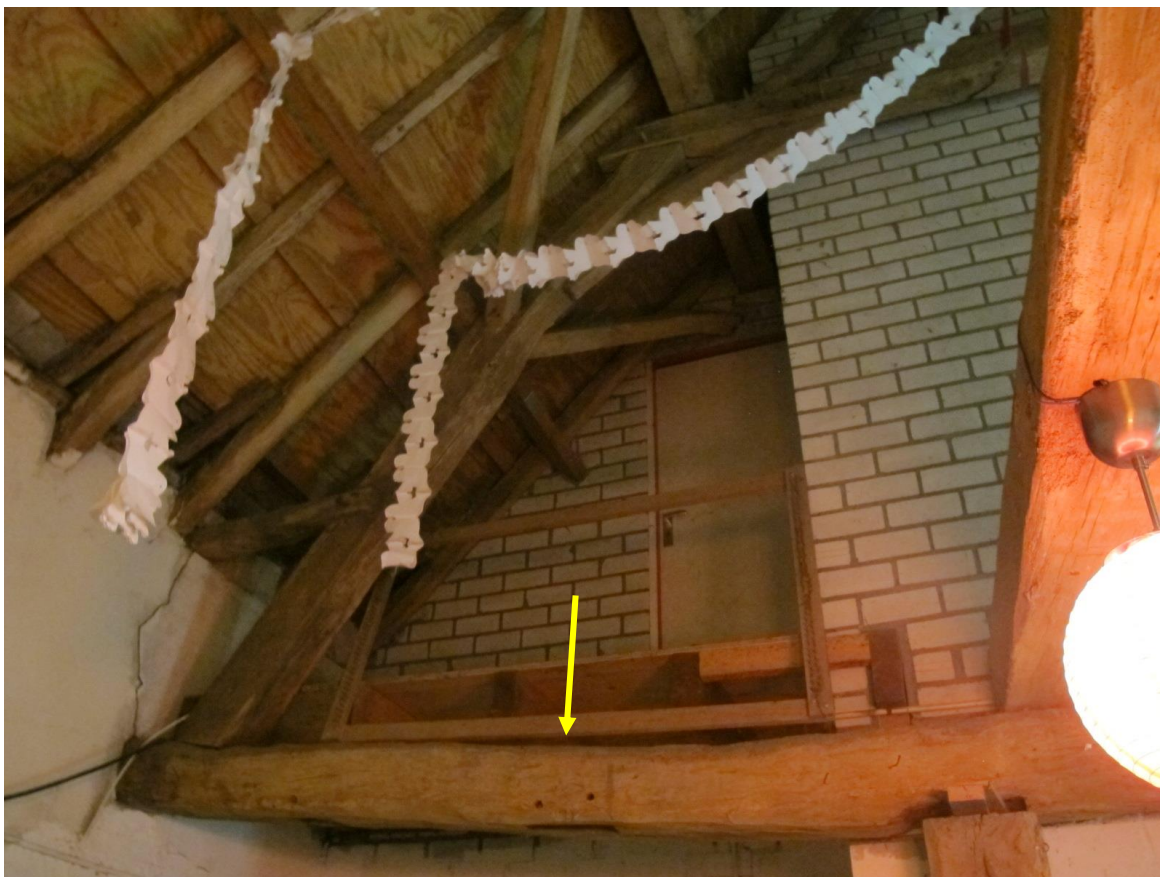
Overhage 16-18; Gebintbalk en kapjuk bedrijfsgedeelte. De gele pijl wijst naar de plaats waar vroeger onder de balk een stijl stond.
