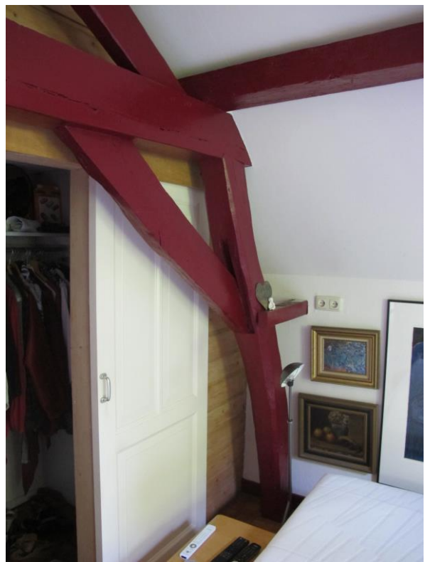
Overhage 14 "Tuinkoepel" Gang met gewelf (links) en oud kapjuk (rechts).
