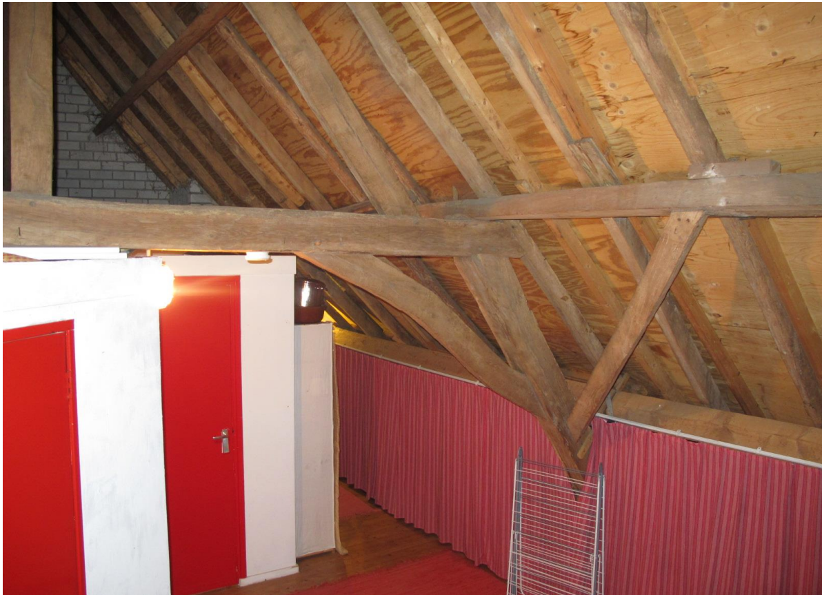
Overhage 16-18; dekbalkjuk zolder bedrijfsgedeelte.
