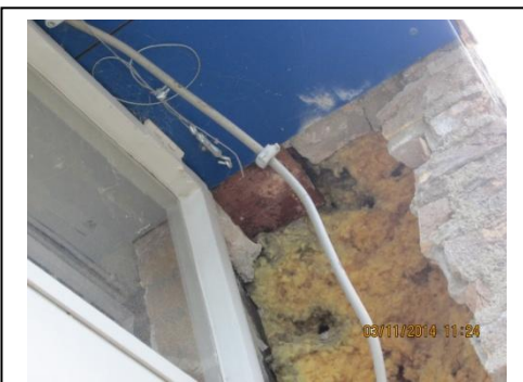
Foto 15: Door sloop open gehakte spouw met steenwol naast vensterkozijn van het schoolgebouw.
