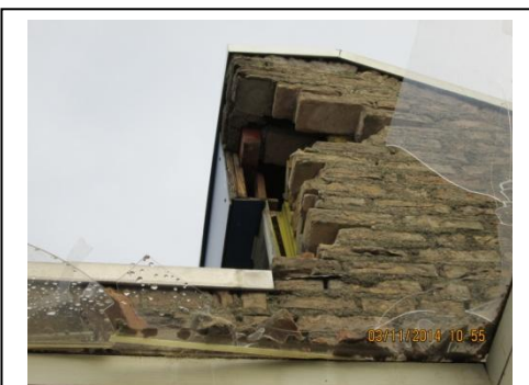
Foto 13: Door sloop open gehakte spouw dakopbouw van het schoolgebouw.
