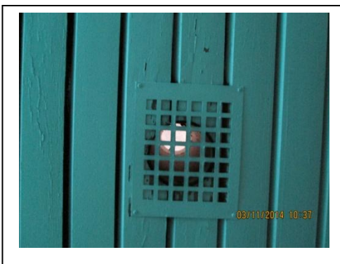
Foto 9: Met rooster afgesloten ontluhtingskanaal in schoolgebouw.
