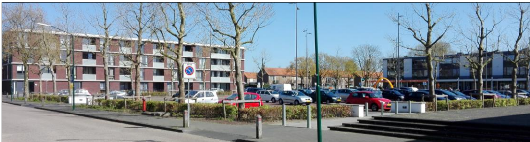
woonbebouwing linkerzijde (fase 2A) en woonbebouwing boven winkels/horeca (fase 2B)
