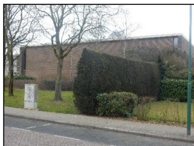
Figuur 4. Kerkgebouw vanaf westen.
