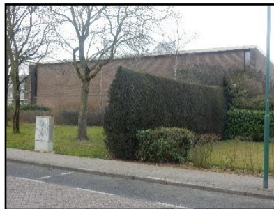
Figuur 4. Kerkgebouw vanaf westen.
