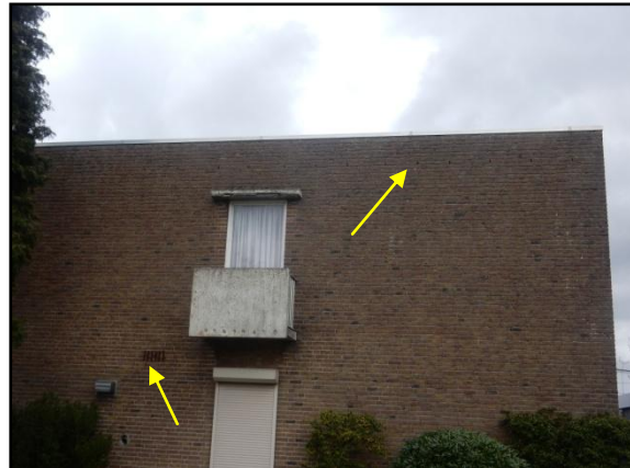
Figuur 11. Geschikte openingen in de pastorie die toegang verlenen tot verblijfplaatsen in de spouwmuur.
