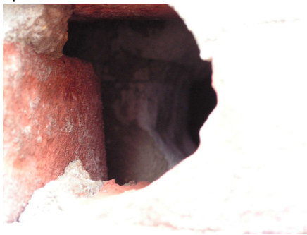
Detailopname van de toegang tot de spouw.
