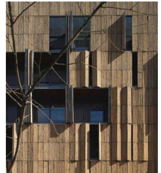
Gesloten houten gevel met gaten
