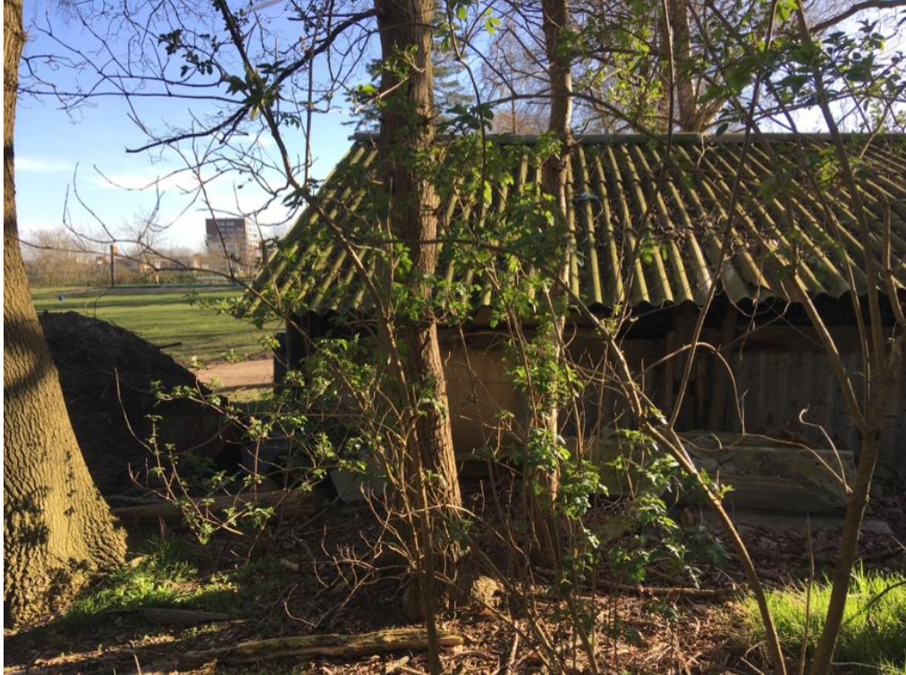
• Afbeelding 15: te slopen schuur (1)
