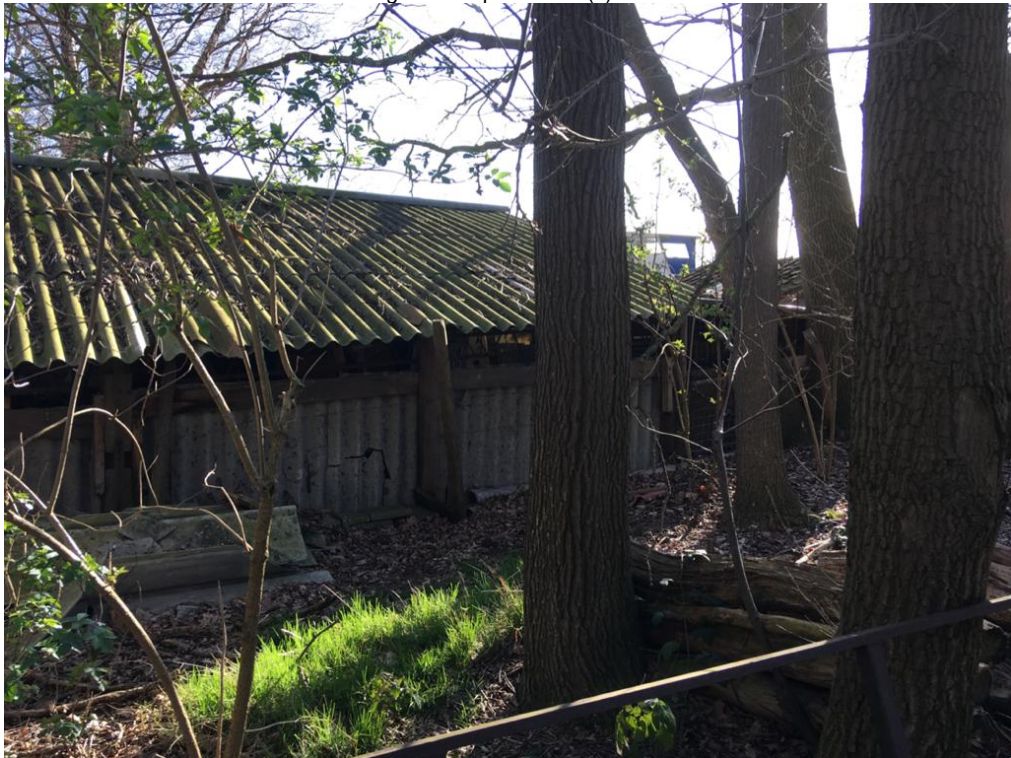
• Afbeelding 14: te slopen schuur (2)
