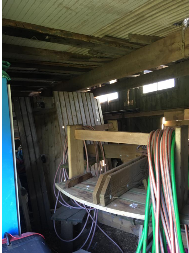
• Afbeelding 7: te slopen schuur
