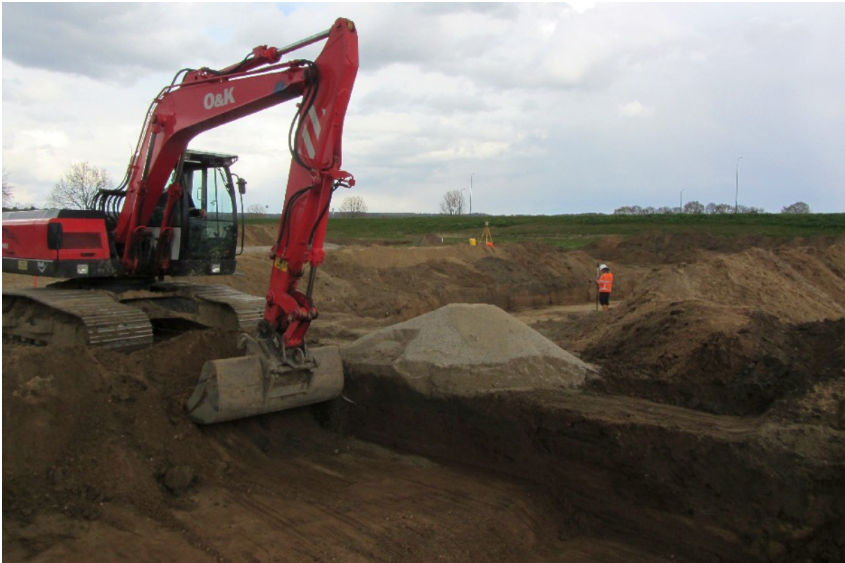
Figuur 4. Sfeerfoto van de aanleg van één van de werkputten. Op de achtergrond is te zien hoe een al aangelegde werkput wordt ingemeten met een Robotic Total Station (RTS).
