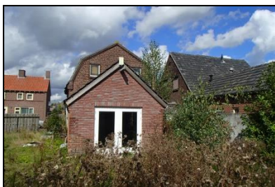
Figuur 6. Achterzijde woning
